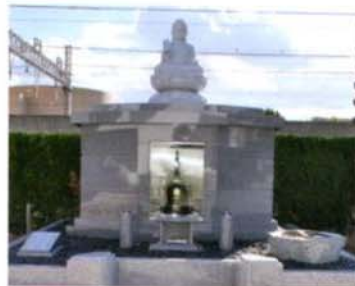
半地下鉄筋コンクリート型
